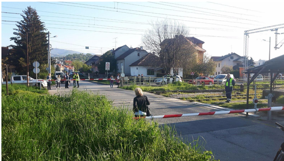
Slika 12. Izgled i način osiguranja ŽCP-a Sokolska
