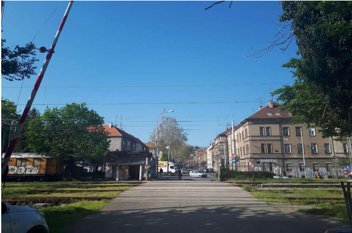
Slika 9. Izgled i način osiguranja ŽCP-a R. Austrije
