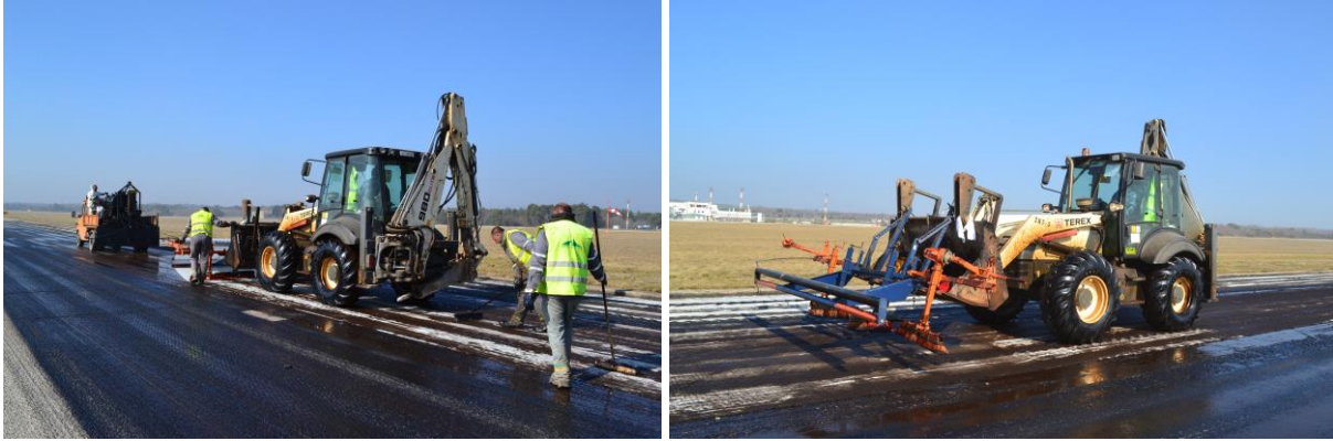
Slika 10. Mehaničko postavljanje staklene mreže na rekonstrukciji uzletno-sletne staze na zračnoj luci Pula
