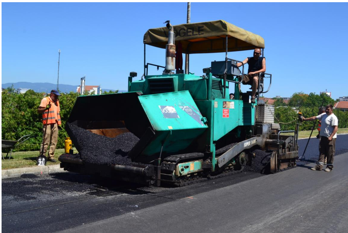
Slika 15. Asfaltiranje finišeom na postavljenu staklenu mrežu
