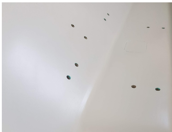
Slika 26. Izgled površine nakon nanošenja kita i finog brušenja.
